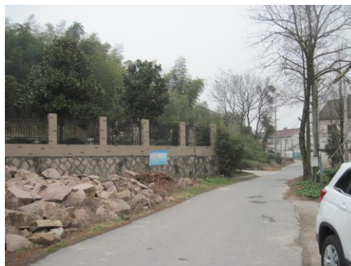
施家山特大桥
