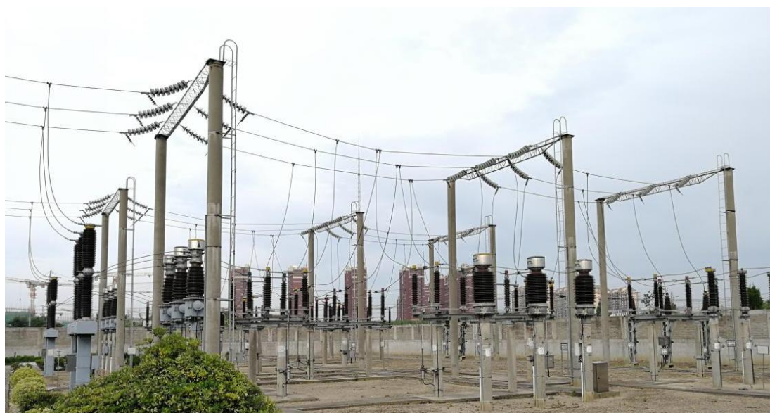
春申牵引变电所选址处实景图
