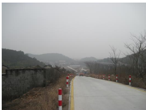
跨申嘉湖高速特大桥
