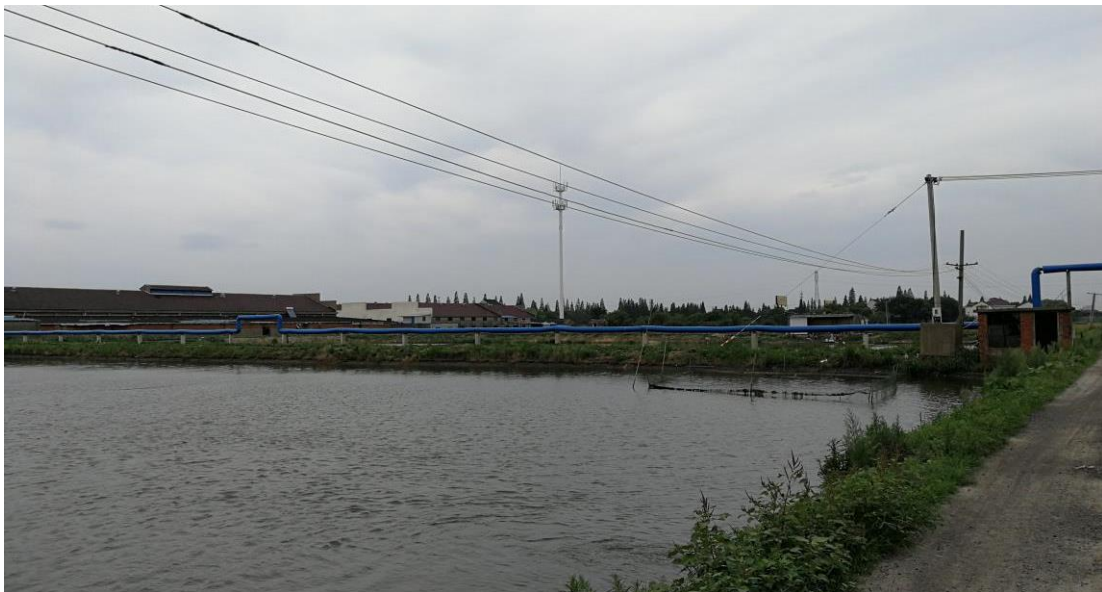
汾湖牵引变电所选址处实景图
