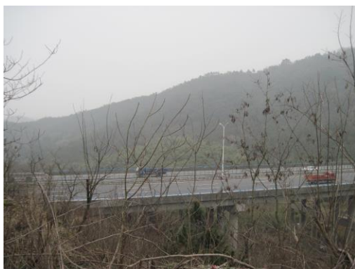
道场山隧道出口
