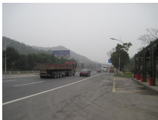
跨 104 国道特大桥
