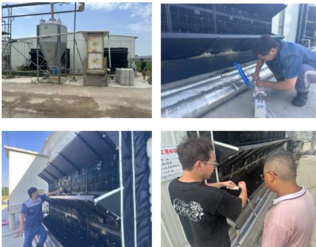
图 5.6-5 现场监测照片
