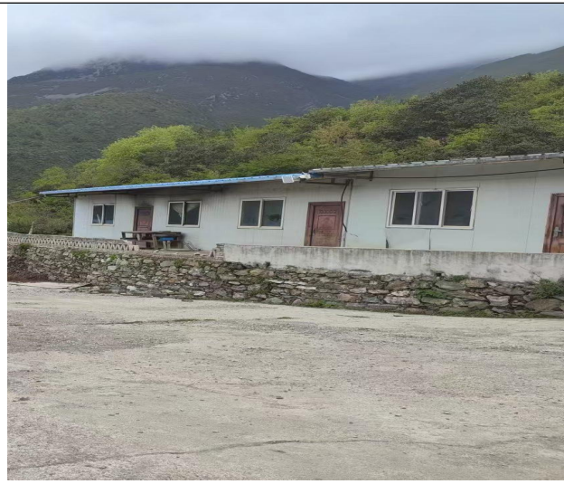
康定站址北侧闲置空房
