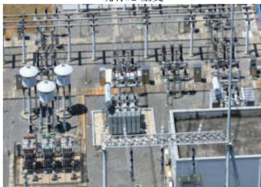
现有#2 主变低压侧 2 组低压电抗器和 1 组电容器
