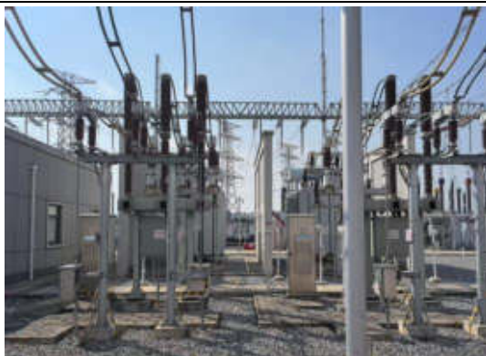
现有#2 主变低压侧 2 组低压电抗器
