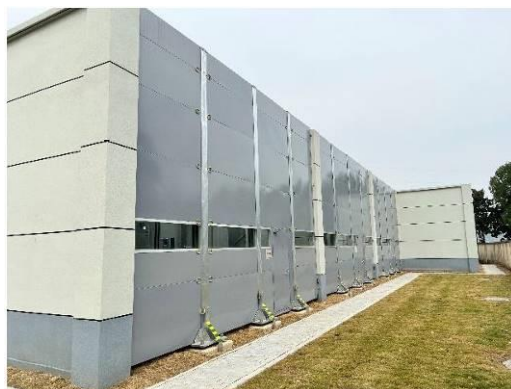
低压电抗器隔声屏障
