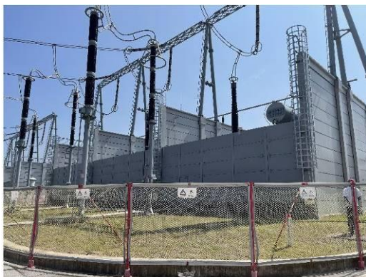
站内已建主变及隔声屏障
