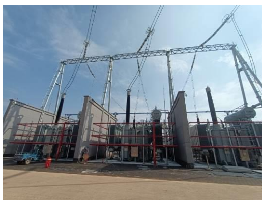
站内已建主变及主变防火墙
