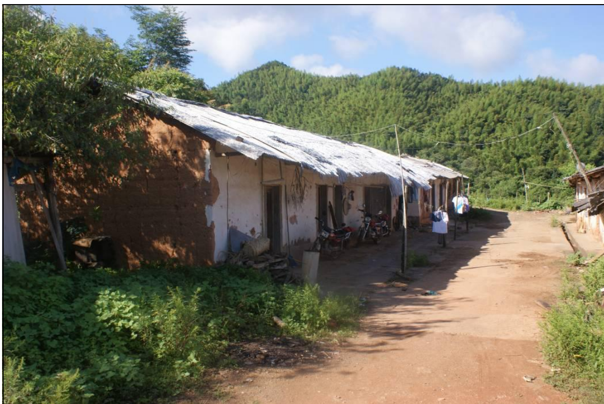
图 5.2-7 黄泥湖矿点遗留住房现状
