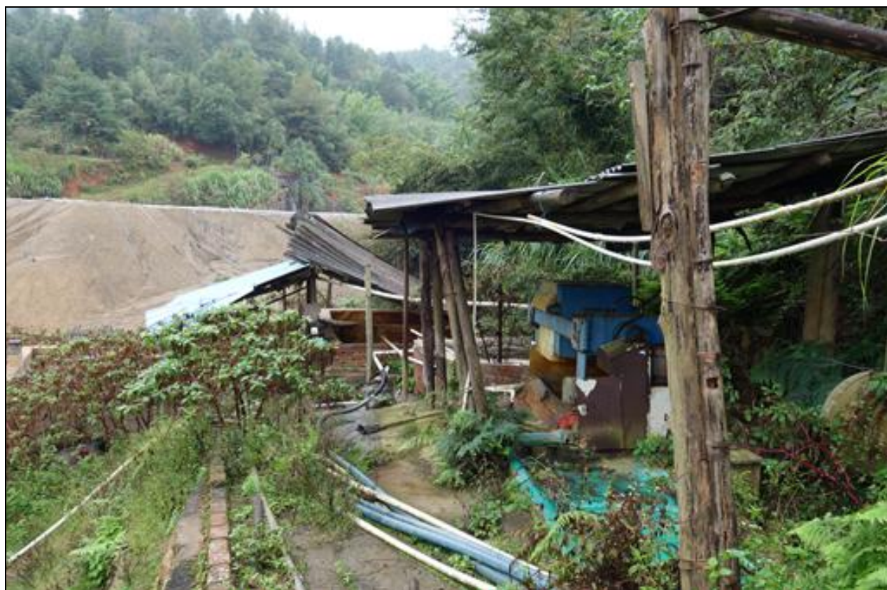
图 5.2-6 黄泥湖矿点遗留设备、管线现状
