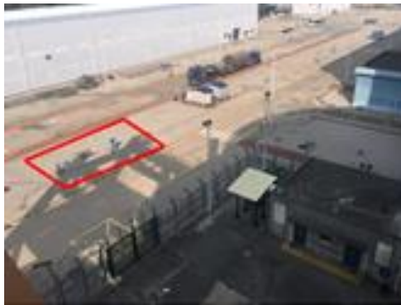
图 1.1 本项目拟建柴油机厂房场址现状
