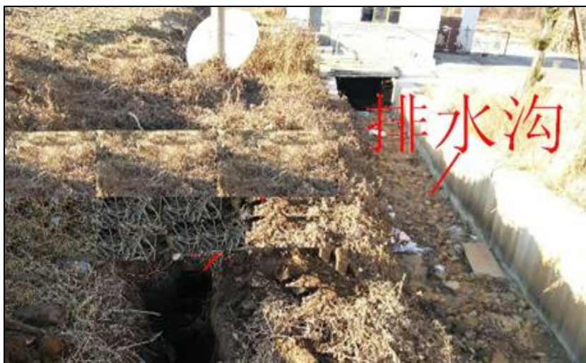
图 5.5-5 废水排放沟现状
