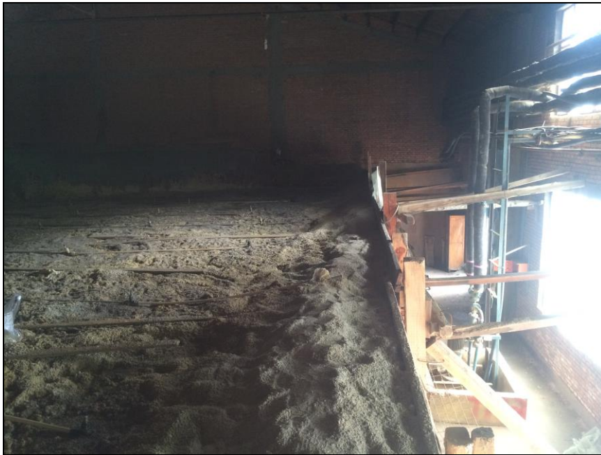
图 5.5-2 堆浸厂房内尾渣现状
