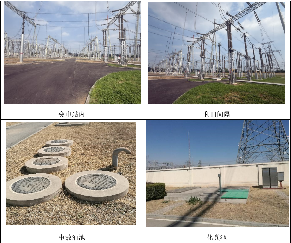
图 3.1-1 房山 500kV 变电站前期主要环保设施
