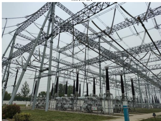
500kV 配电装置区
