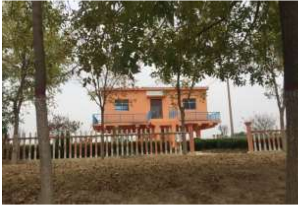
山东东营段神仙沟引黄闸
