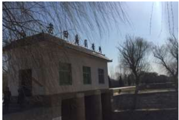
河南焦作段老田庵引黄闸
