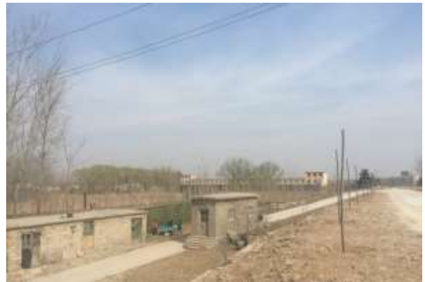
山东聊城段位山引黄闸
