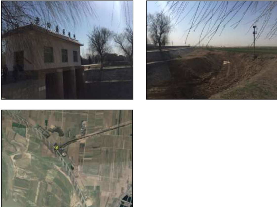
图 2.5-6 老田庵闸现状图
