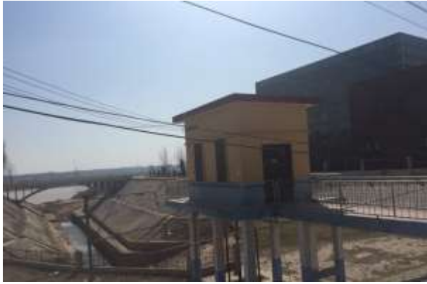
河南濮阳段影堂引黄闸
