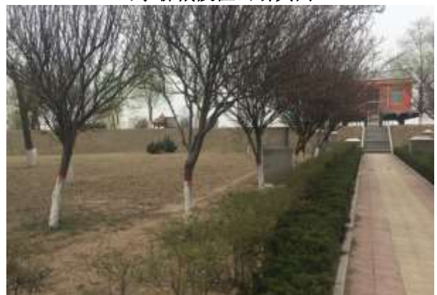
山东济南段大王庙引黄闸
