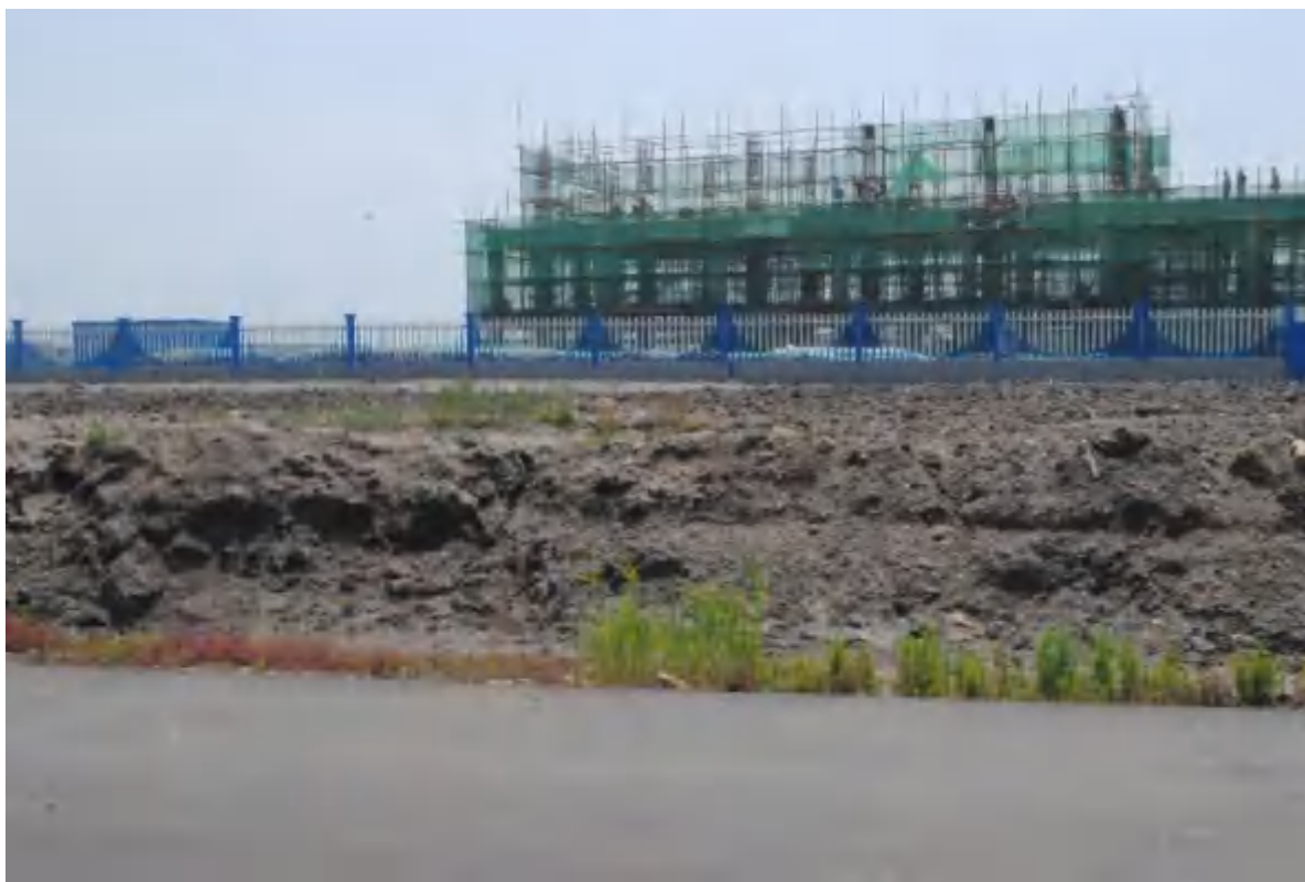
图 7.7- 8 起步区南区正在修建的污水处理厂厂房设施现状
