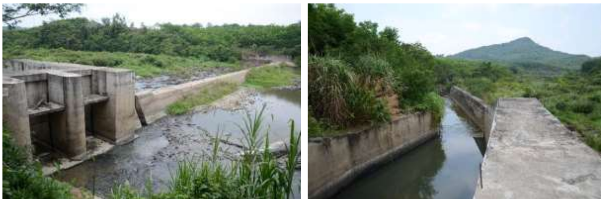
同兴水电站大坝(未完工)
