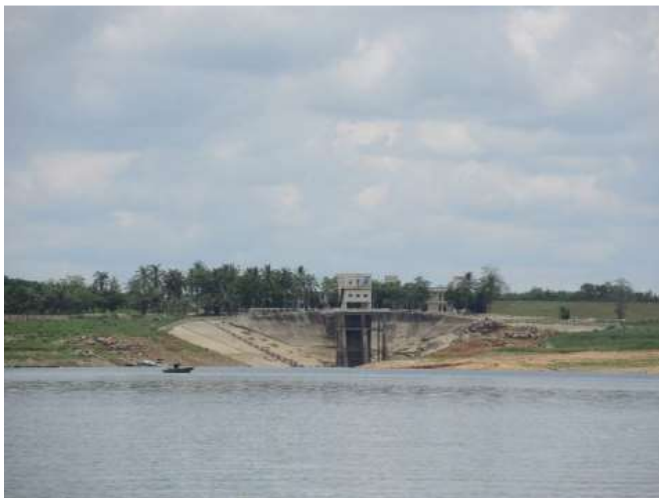
图 5.3-3 南丰电站取水建筑物
