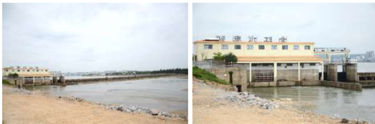
金江水电站大坝
