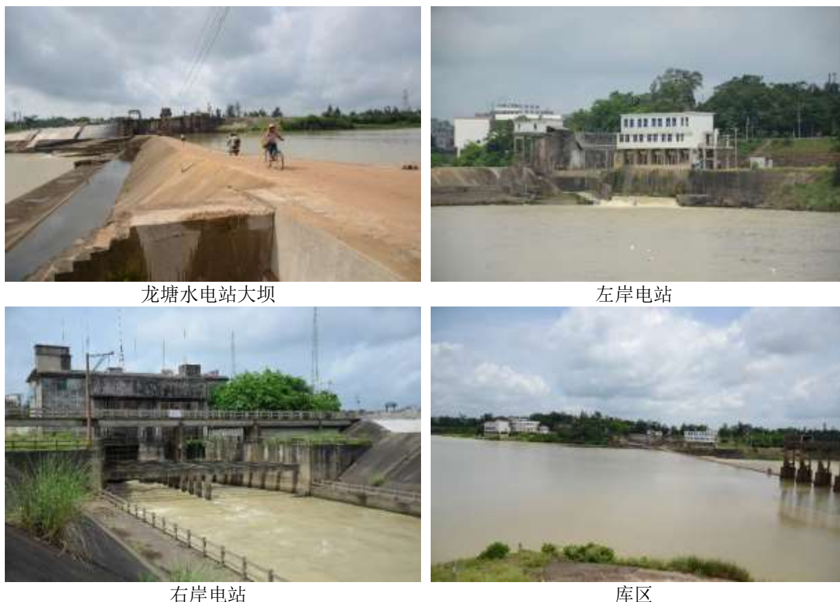
图 2.1-5 龙塘水电站现状面貌
