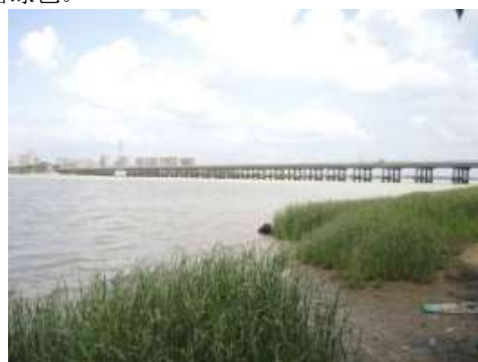
河口：该采样断面位于南渡江第一大桥下游约 500m。河面开阔，宽约 600m，两岸城镇，岸边有护坡、道路，河滨带水生植物丰茂，底质为细砂，水色浑黄，流速较缓，约 0.2m/s。
