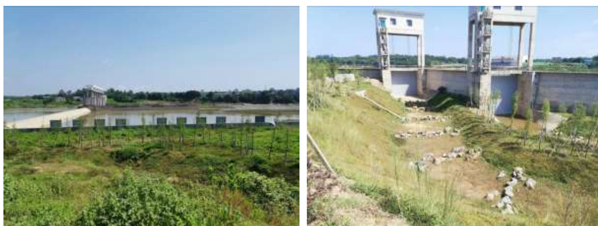
主体已建成的东山水库闸坝
