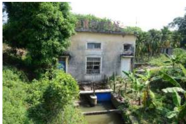
阳江农场一级电站厂房
