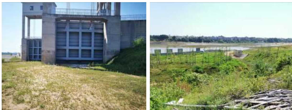
出口 进口 图 8.4-8 东山闸坝仿自然旁通道建设面貌（2019 年 8 月照片）
