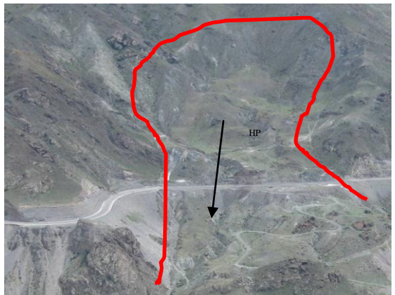
HP2 滑坡体全貌
