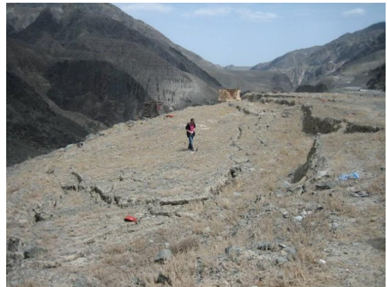
HP1 滑坡前缘拉裂缝
