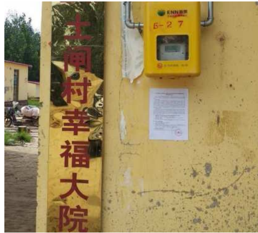
聊城市东昌府区梁水镇土闸村
