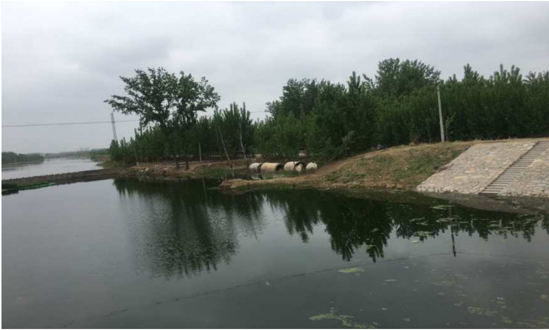
图 6.6.6-1 周公河右侧新建排污管道节制闸现状
