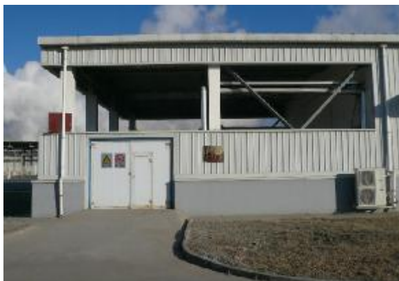
危险固废临时堆存库外观
