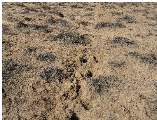
双马一号煤矿采空区上方裂缝
