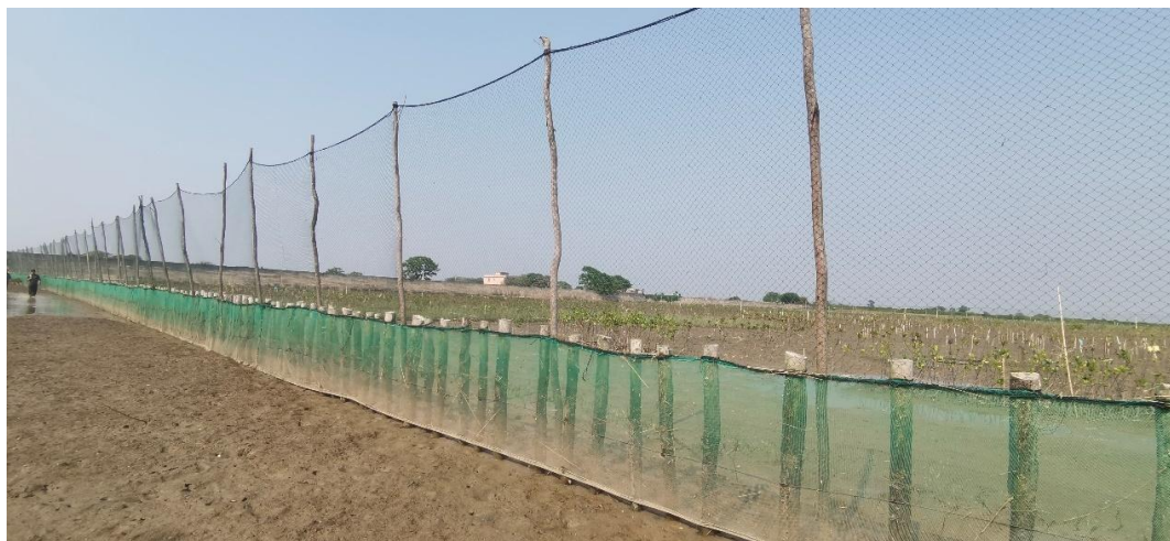
图 9.5.4-9 缓流消浪栅栏+围网结构
