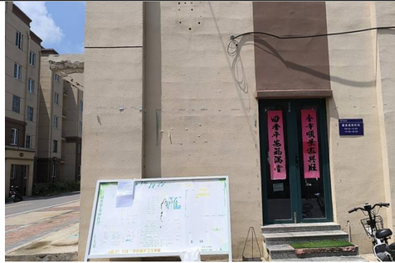
蒙洼一期安置小区
