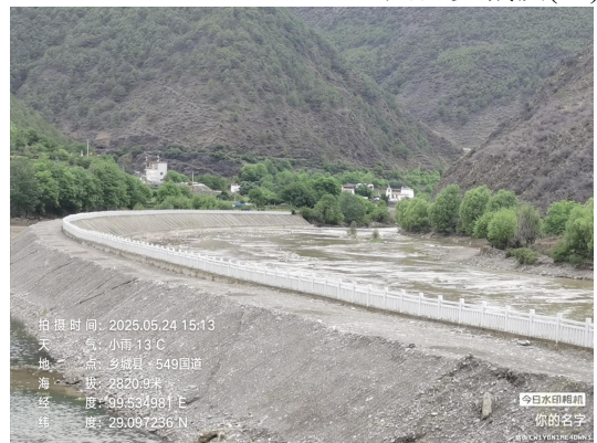
定曲乡城段硬化岸坡
