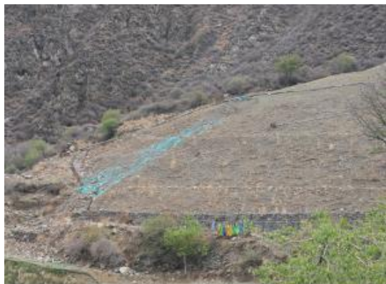
拉哇必英沟表土堆存场冲沟修复
