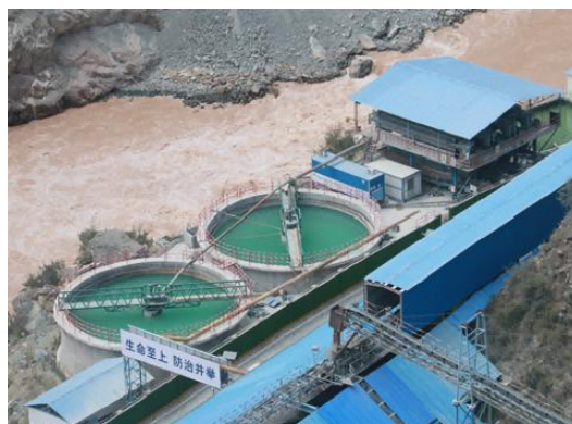
拉哇砂石加工系统废水处理设施
