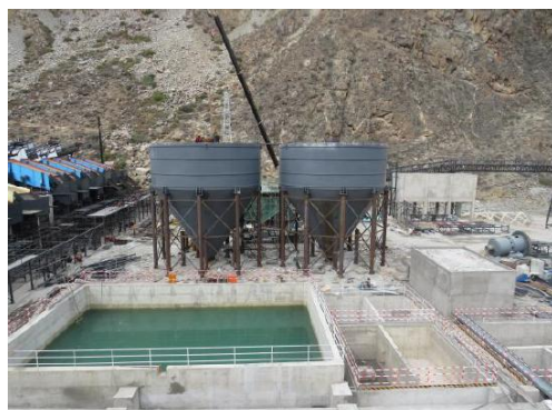
旭龙高线砂石系统废水处理设施
