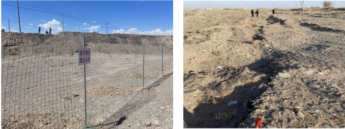
建顺煤矿采煤塌陷区围栏及警示牌以及开采裂缝治理
